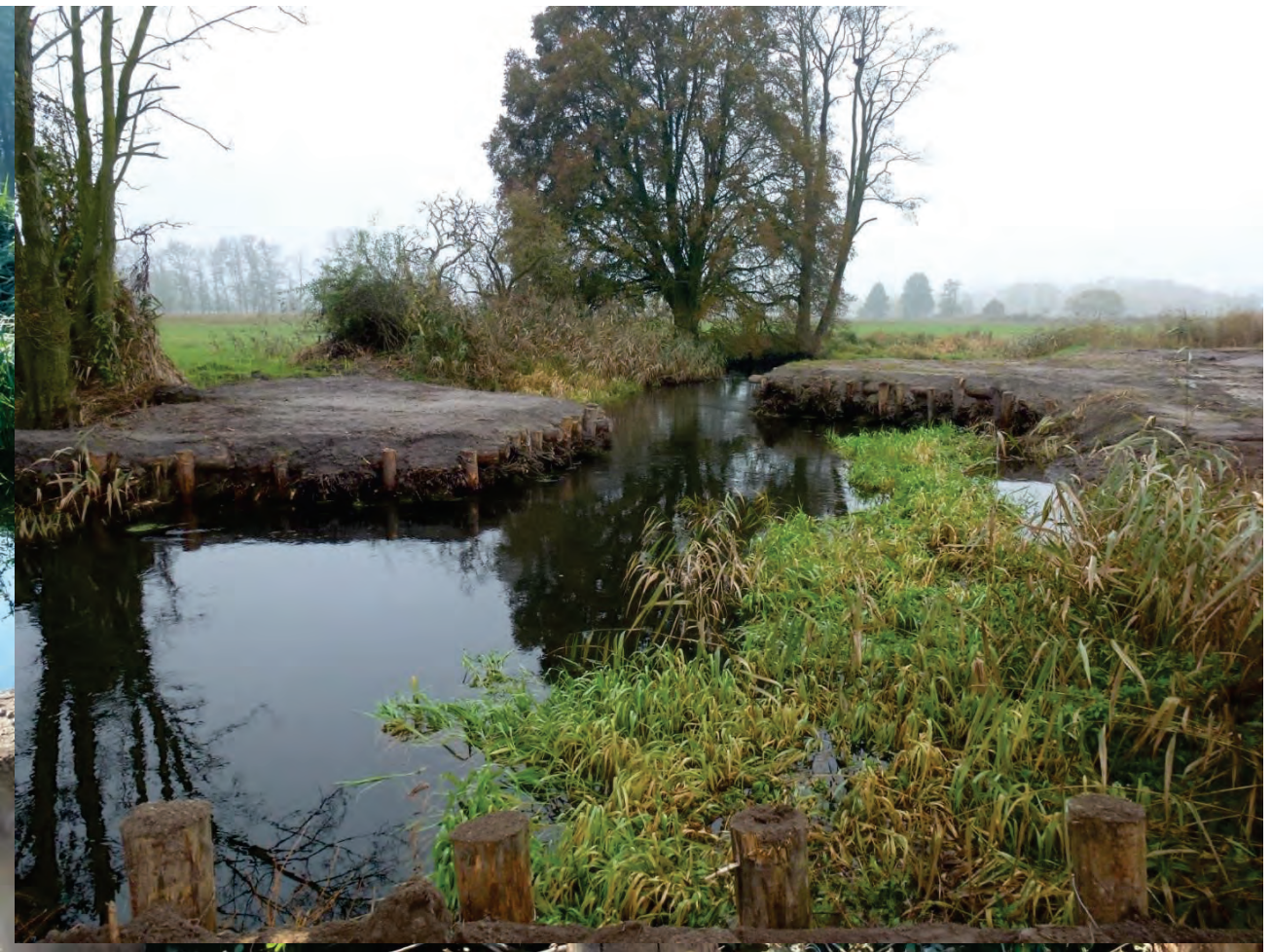
Buhnen aus Holz, Sand und Torf, LfU – W 26, Schnelle Havel
