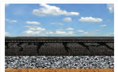
Sanierung von Asphaltflächen
